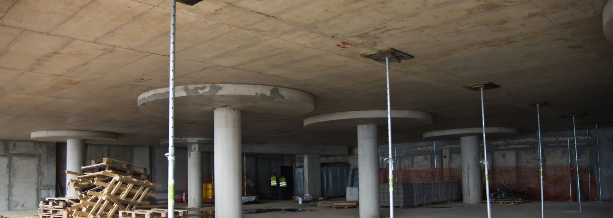
Obrázek nahoře: Pohled na betonové stropy s hlavicemi v prostoru restaurace
